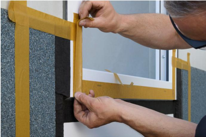
Das Bild zeigt die fertiggestellte Abklebung am Beispiel Fenster-Blendrahmen mit Sockeldämmprofil, Einbau in der tragenden Wandkonstruktion (monolithischer Einbau).
