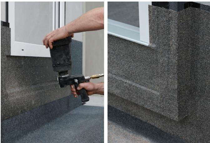
Wir empfehlen, die abgedichtete Fläche mit einer zusätzlichen Schutzlage (z.B. Kunststoffvlies 300g/m<sup>2</sup>) zu überdecken, um sie vor mechanischem Abrieb (z.B. durch Steine) zu schützen, wenn das Erdreich an dem Sockel aufgeschüttet wird.
