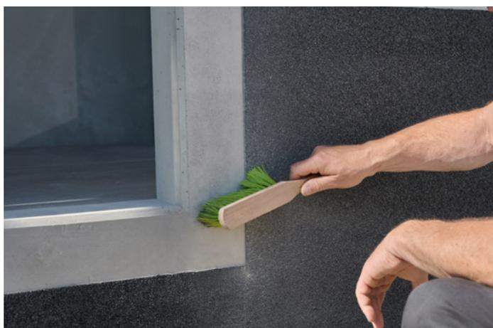
Sämtliche auf den Untergründen vorhandene Schutzfolien sind im Bereich der Abdichtung zu entfernen.
