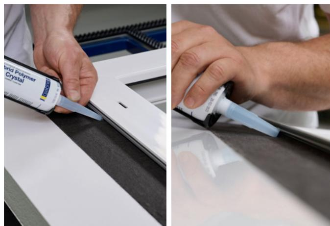
**Wichtig:** Bei Bodenschwellen ist darauf zu achten, dass die Wasserabtropfkante offen bleibt: die vorderste Schwellenkammer nur 40 mm ab der Aussenkante der Ecken mit dem blaugelb Hybrid Polymer Crystal verschliessen. Überstehendes Material abziehen.
