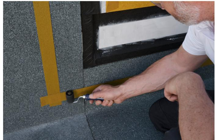
Das Bild zeigt die fertiggestellte Abklebung am Beispiel Fenster-Blendrahmen mit Sockeldämmprofil, Einbau in der tragenden Wandkonstruktion (monolithischer Einbau).
