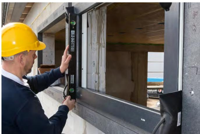
2. Zabilježite specifikacije pričvršćivanja / razmake pričvršćivanja (**Dodatak III**) prilikom uvrtanja okvira prozora u blaugelb Trioterm®. Bitno je da ih promatraste. Koristiti samoblauigelb Frame vijci FK/ZK-T30 7,5 mm za pričvršćivanje elemenata prozora izravno u blaugelb Trioterm®-profil. Nemojte prethodno bušiti blaugelb Trioterm®-profila.
