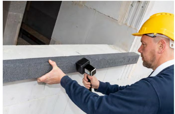
Primijenjeni blaugelb Hybrid Polymer Power Fix djeluje odmah kao pomoći fiksator. Njegovo visoko početno prianjanje znači da profil odmah prianja na željenu poziciju. Male prilagodbe njegovog poravnjanja bit će moguće do oko 20 minuta nakon nanošenja na bazu sidra.
