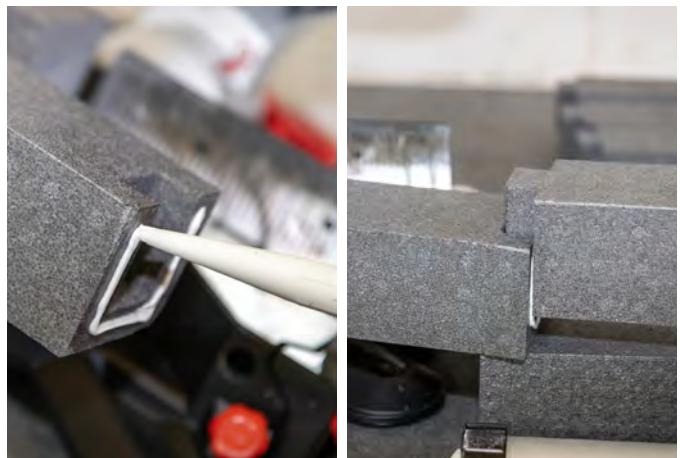
U području spoja lastinog repa potrebno je izvesti vijčani spoj (na gornji profil) na udaljenosti od 100 mm od spoja, bez obzira na uobičajene razmake pričvršćivanja.
