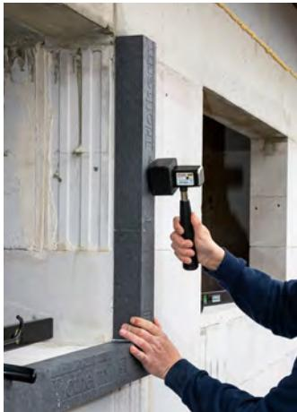
5. Namjestite gornji blaugelb Trioterm-profil. Zabrtvite čeone spojeve bočnih profila pomoću blaugelb Hybrid Polymer Power Fixa.
