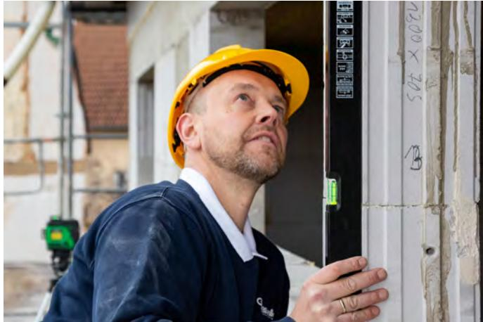
Površine baze ankera moraju se provjeriti na ravnost te okomito i vodoravno poravnjanje. Uzmite u obzir tolerancije središnje linije i tolerancije zida.
