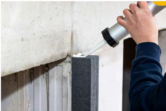
6. Postavite blaugelb Trioterm-profil i čvrsto ga pritisnite na bazu ankera i bočne profile.
