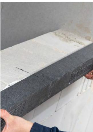
2. Pritisnite pripremljeni blaugelb Trioterm+profil čvrsto na bazi ankera, pazeći da ostane u označenom položaju. Profil se može čvrsto pritisnuti čekićem s gumenim nastavkom.
